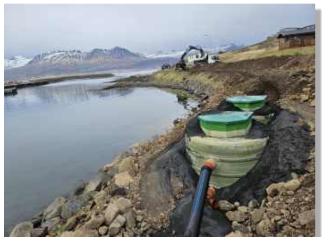
Fyrsti áfangi í endurnýjun fráveitu á Djúpavogi. Dælubrunn framan við Hótel Framtíð
